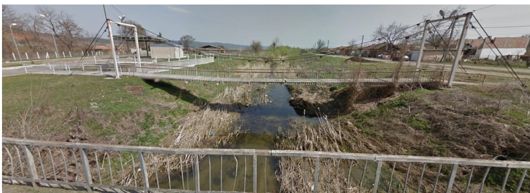
р. Хаджидере, северен край на с. Гълъбец, местен път Гълъбец - Горица (поглед надолу по течението)
