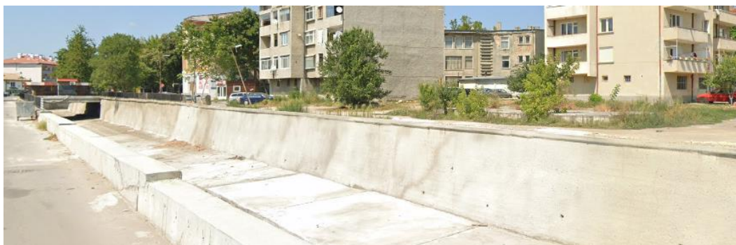
Крива река, Нови пазар, ул. Марица, бетонна корекция (450 т) (поглед нагоре по течението)
