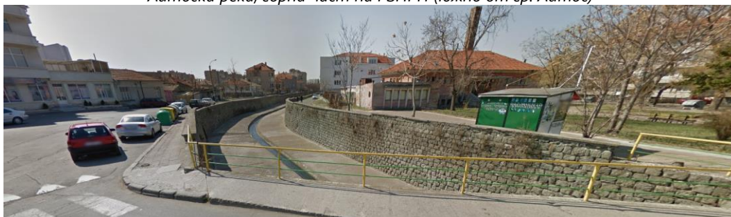
Облицована с бетон корекция в гр. Айтос Фигура 1.1 Общи снимки на района (източник: Google Earth)
