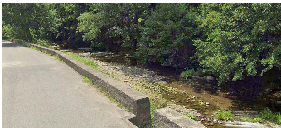
Нейковска река - с. Катунице, къса защитна стена отляво на реката покрай урбанизираната територия
