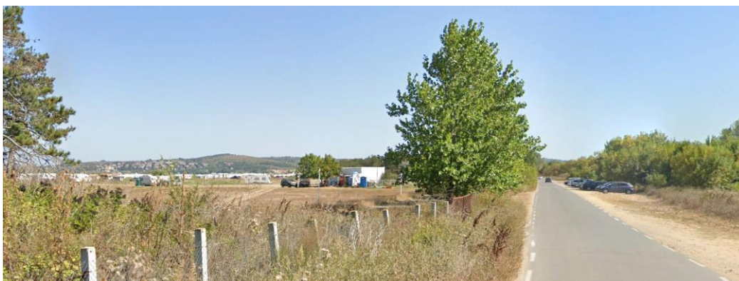
Природен резерват и плажна зона зад републикански път 99, засегнати от речни наводнения. В далечината вляво могат също да се видят възвишения, спускащи се към пристанищата в Созопол, които са предразположени към мащабни морски наводнения при обезпеченост 5%. (източник: Google Earth)
