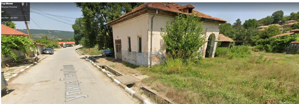
Отводнителна система в с. Бял бряг
