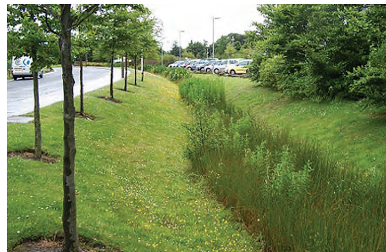
Затревен канал като компонент на УОС
