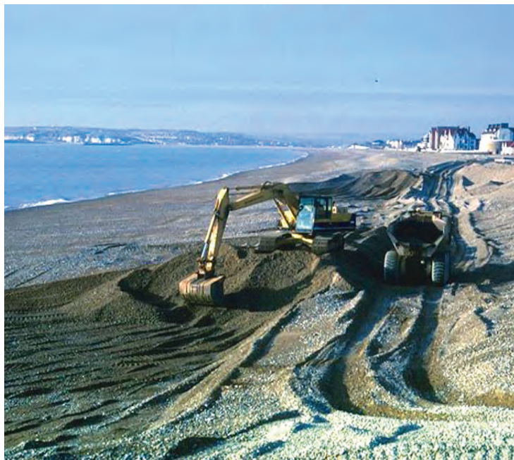
Рециклиране на плажна ивица чрез връщане на пясъчния материал от зоните на отлагане към нарушените участъци
