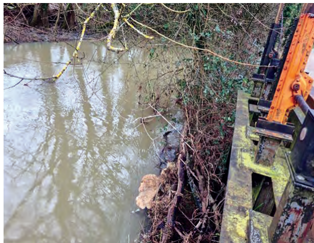
Запушване на шлюз от дървесни отпадъци
