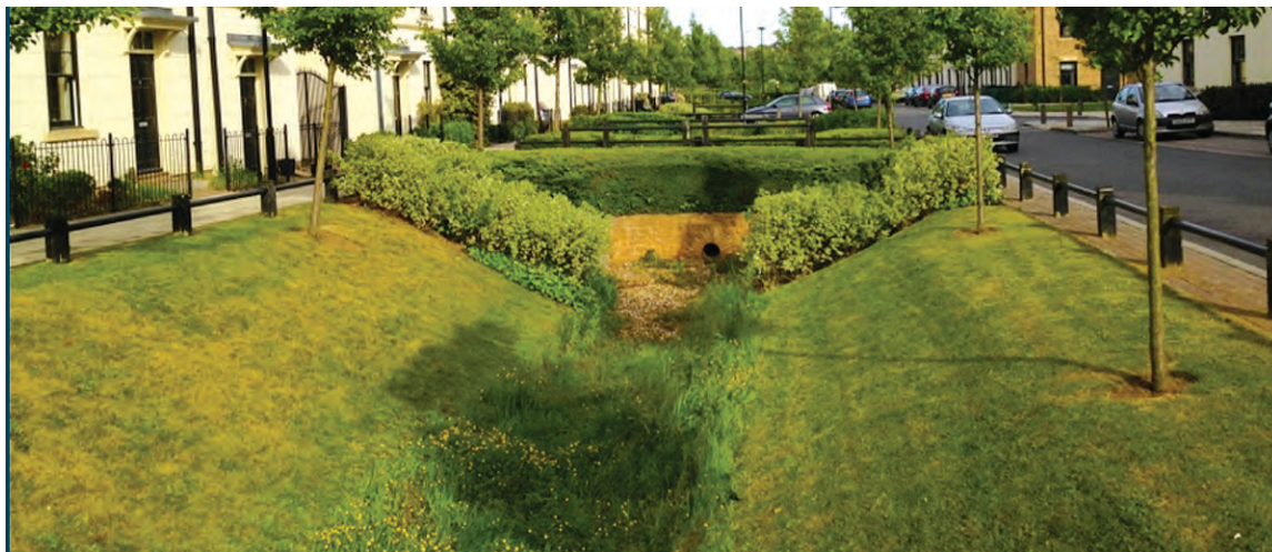
Отводнителен канал като компонент на УОС
