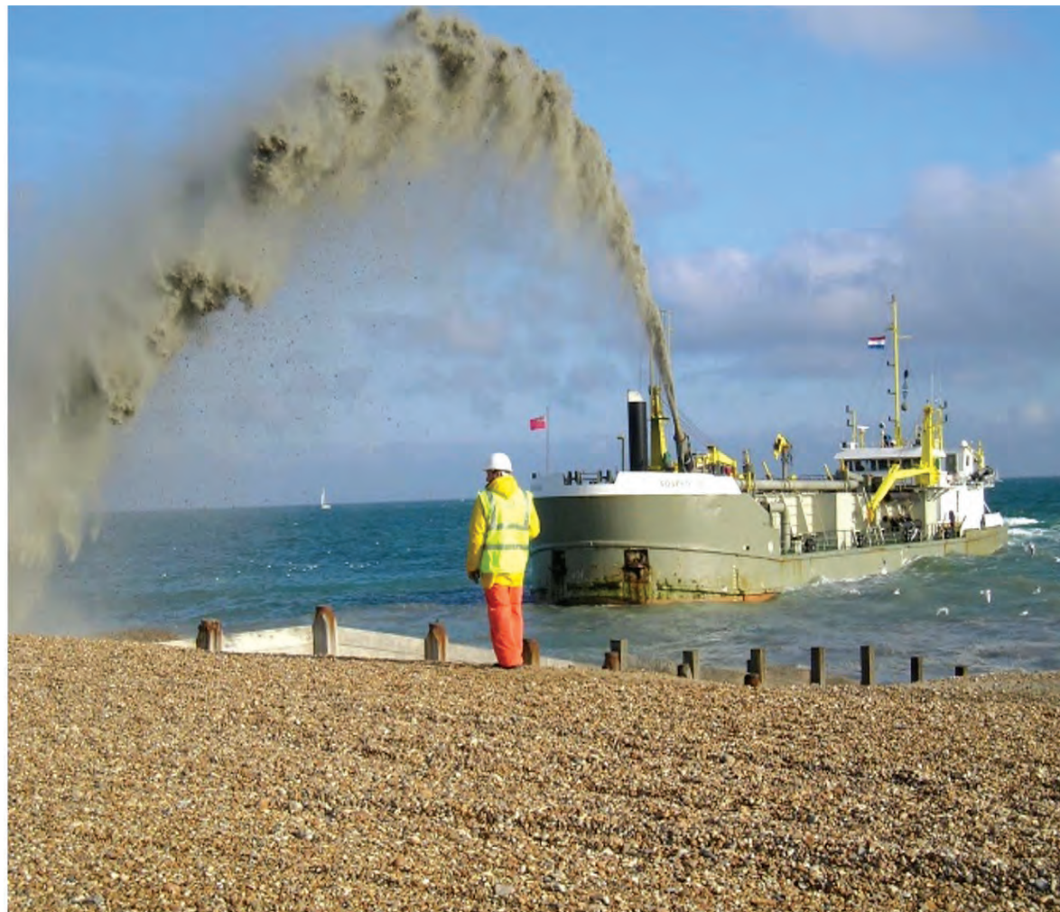
Подхранване на плажната ивица с материал, доставен по море чрез драгиране
