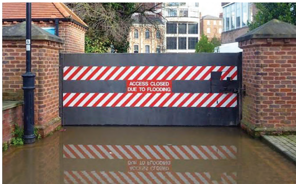
Подвижен контролен орган (шлюз) на брегозащитна стена срещу наводнения за осигуряване на достъп. При наводнение се затваря.
