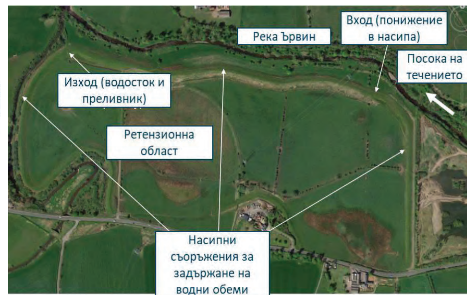
Ретензионна област за външно водозадържане: р. Ървин, Шотландия
