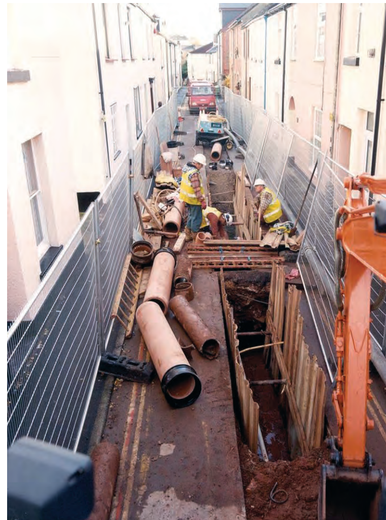
Изграждане на канализационен колектор
