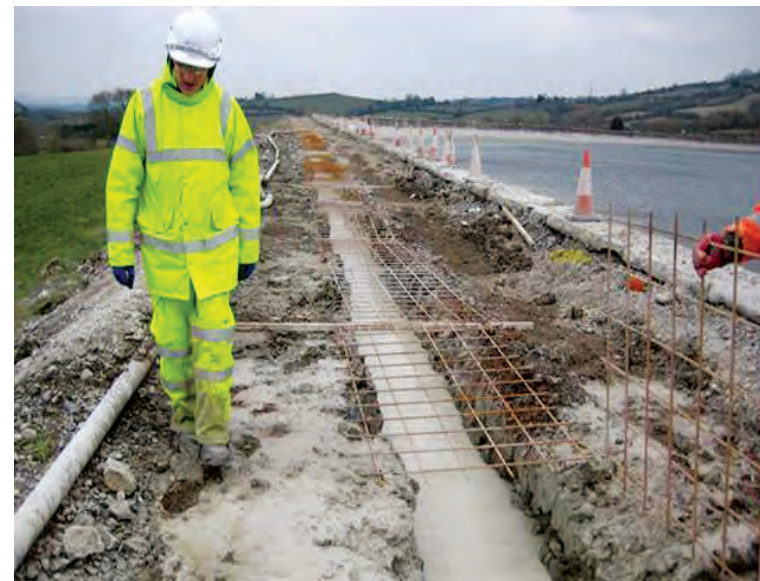
Ремонт на короната на язовирна стена
