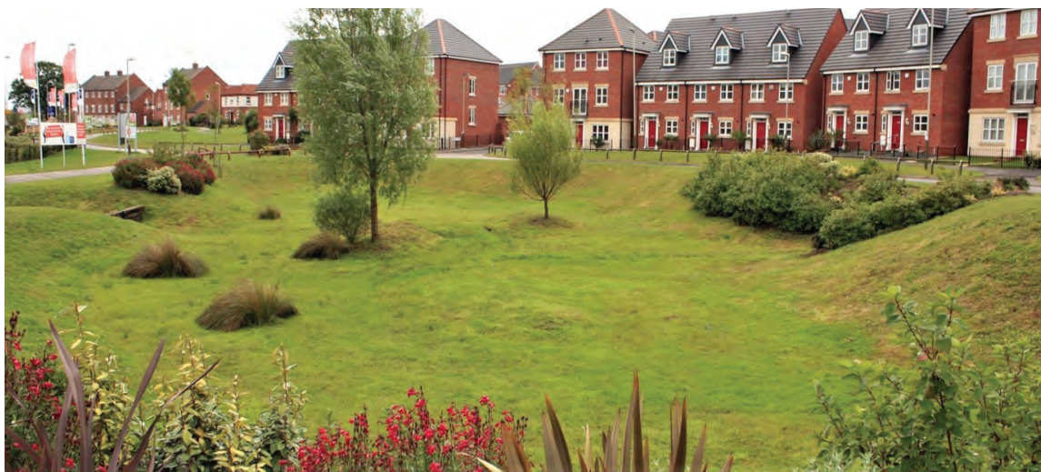
Водозадържащ басейн като компонент на УОС
