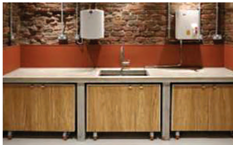
Подвижен кухненски блок в устойчиво на наводнения предприятие
