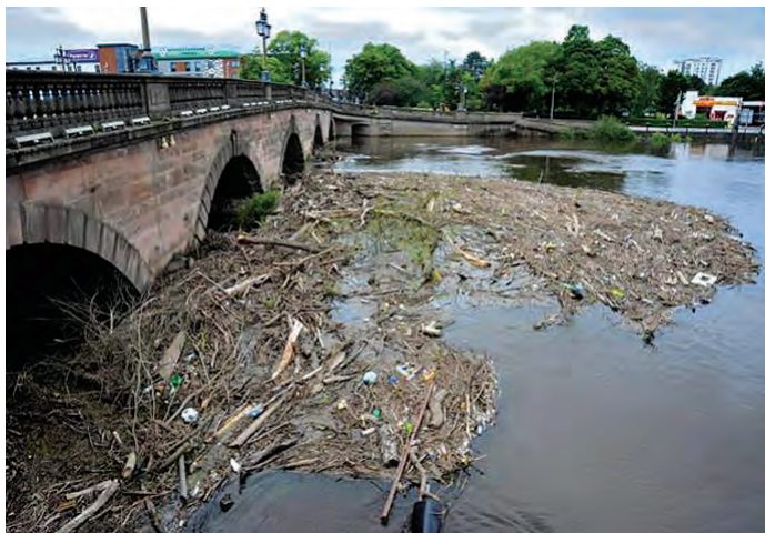
Запушване при мост, причинено от плаващи дървесни и битови отпадъци
