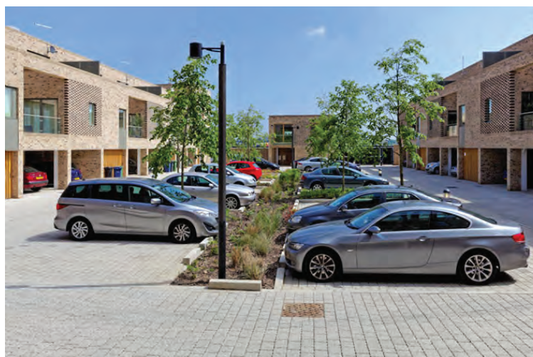
Пропусклива настилка като компонент на УОС
