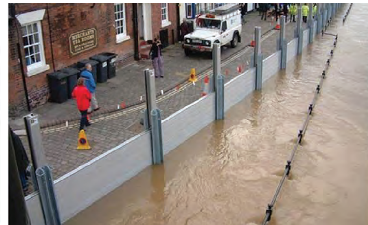
Разглобяемо защитно съоръжение по време на наводнение. Състои се от подвижни стоманени колони и дамбалкени/греди (Великобритания)
