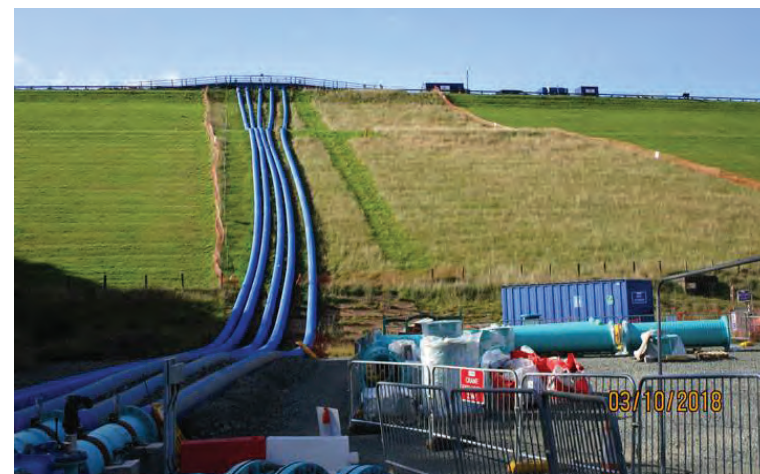
Временен сифонен преливник, за да извършване на ремонтни дейности при изпускателните съоръжения на язовирна стена
