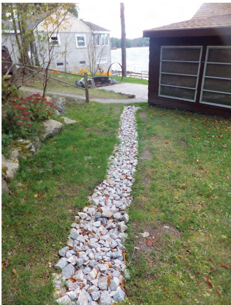
Инфилтрационна поповна траншея като компонент на УОС
