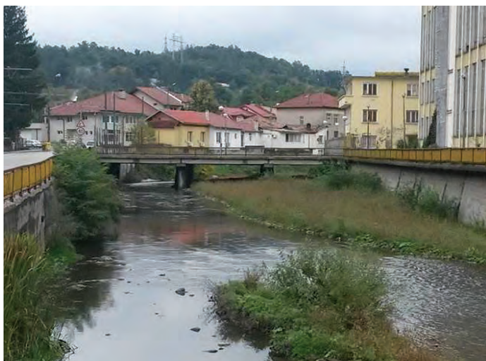
Запушване на мост в резултат на отлагане на наноси (Габрово, България, 2015 г.)
