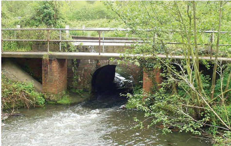
Примери за мостове, които ограничават проводимостта
